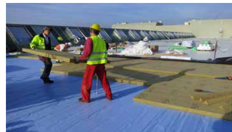
Bild 14: Verlegung Hardrock 040 Quelle: ROCKWOOL
