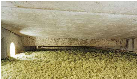
Bild 10: Einblasdämmung Fillrock RG | Quelle: ROCKWOOL
