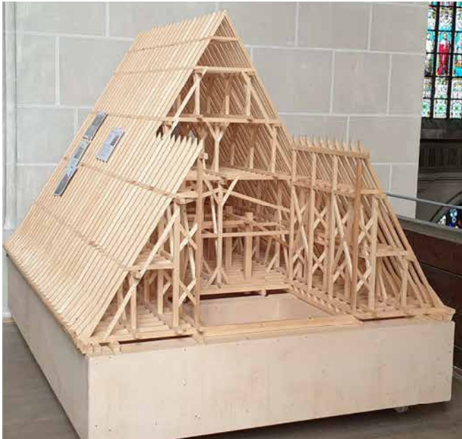
Bild 2: Dachtragwerk Basilika St. Martin, Amberg, Modell 1:15 Grundsteinlegung 1421, Spannweite 27,80 m, Höhe 24 m Quelle: Josef Hauer, Karl Müller
