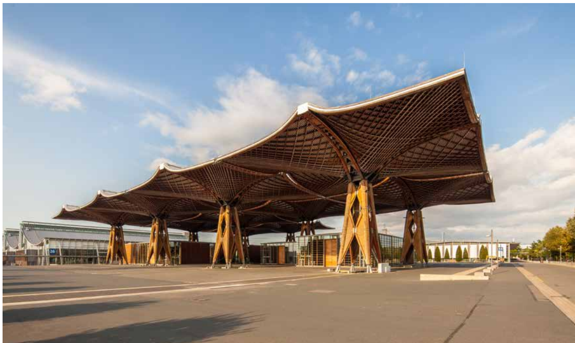
Bild 5: EXPO-Dach Hannover Messe 2000 | Quelle: Deutsche Messe
